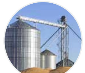
Almacenes y silos
